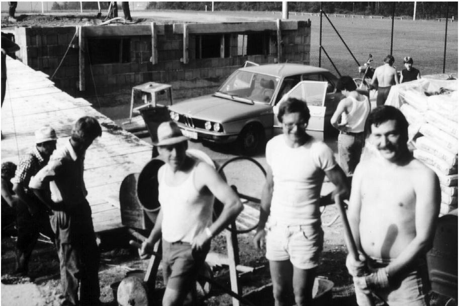
Betonieren der Geschoßdecke
